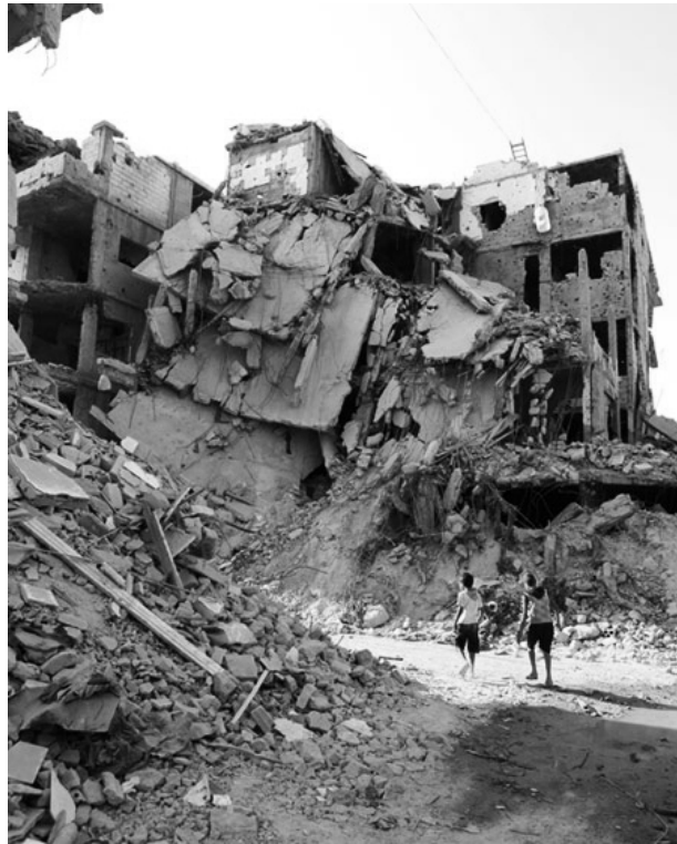
Zerstörung im Neuen Camp, September 2009. Foto: M. Cassel.
